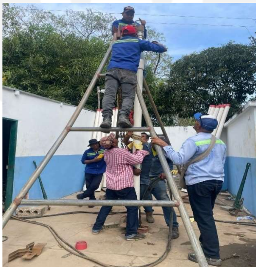
Instalación nueva tubería – bomba principal
