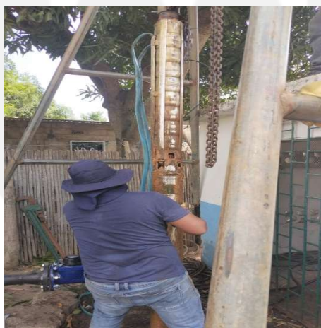
Extraída de tubo y bomba
