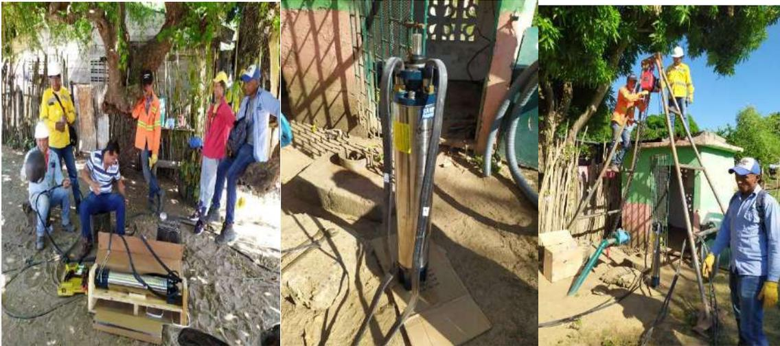
Mantenimientos e instalación de una bomba nueva de 40hp en la estación cristo rey dicho cambio fue realizado por la quema de la bomba anterior por el fluido eléctrico.
