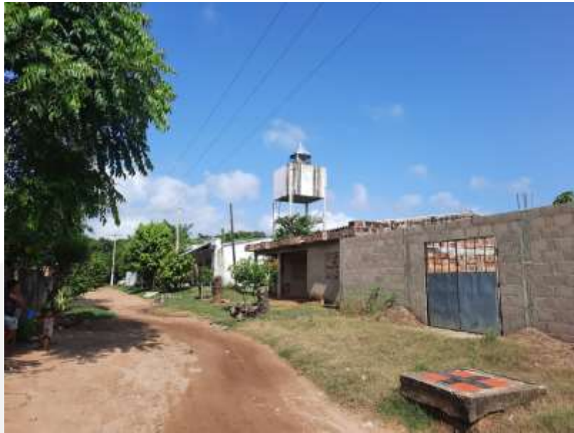
Ilustración 3. Tanque Elevado SAN FERNANDO
